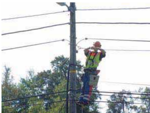
Εικόνα 27. Εγκατάσταση εναέριων καλωδιώσεων.
