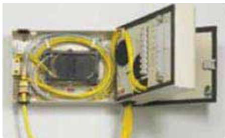
Εικόνα 12. Κουτί διακλάδωσης.
