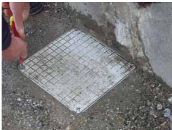
Εικόνα 9. Κάλυμμα Φρεατίου μέσα στο οικόπεδο ιδιοκτησίας
