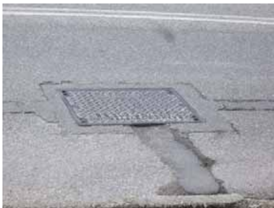
Εικόνα 8. Κάλυμμα φρεατίου πρόσβασης από τον δρόμο στην ιδιοκτησία
