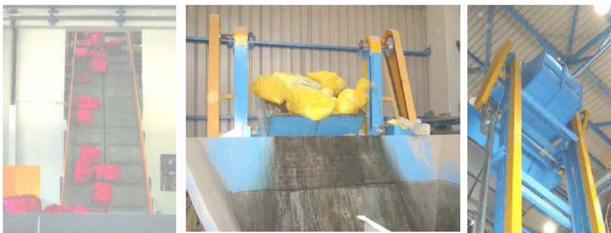
Εικόνα 30: Τροφοδοσία του κλιβάνου με ταινιόδρομους και με αναβατόριο (ΕΣΔΚΝΑ, 2007).
