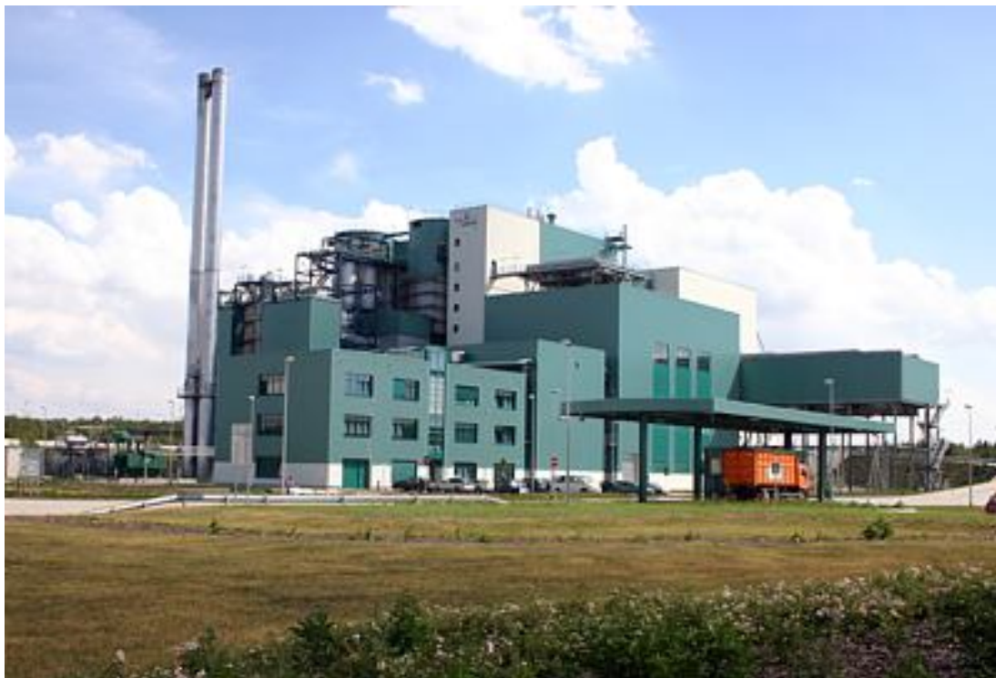
Εικόνα 1: Μονάδα αποτέφρωσης Α.Σ.Α. στη Γερμανία (TA Lauta, 2008).
